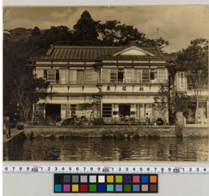
図2 関東大震災による被災、復興移転後の昭和10年代の嶽影楼
