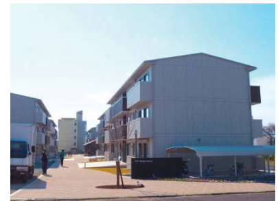
〈全棟完成したTUTグローバルハウス〉
