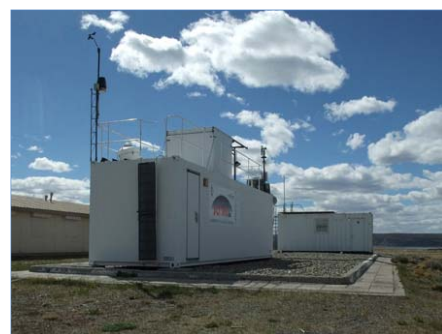
観測サイトのオゾンライダーコンテナ
