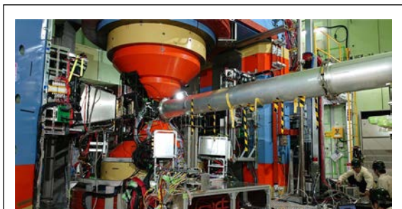
図1 建設中の実験装置
