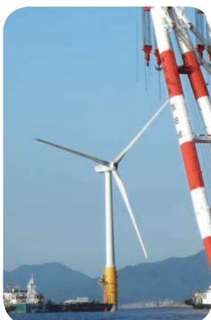
図2 ハイブリッドスパー型実証機(2MW)のフルスケールモデルの完成直後の様子(2013.9)
