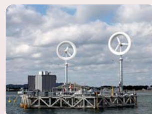
図2 博多湾に設置された海上風力発電浮体(平成23年12月)
