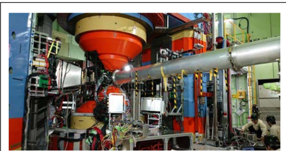
図1 建設中の実験装置
