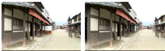
図4 屋外での DR 処理 (工事中の看板を除去)
