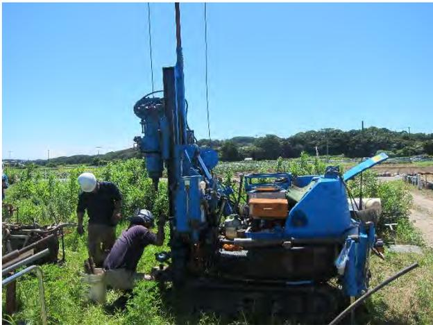
専門業者の方のボーリング掘削の作業
