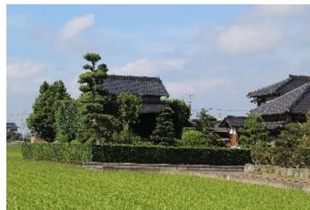
図4 水屋・水塚（茨城県取手市）
