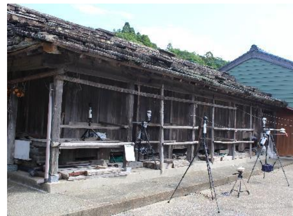
図1 環境実測調査の様子（対馬の石屋根のコヤ）
