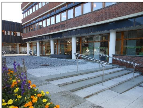
International Office の外観
