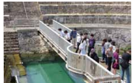
宮古島におけるオンサイト実習では離島におけるインフラを学んだ(写真は浄水施設)
