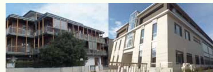
船哲房の全景、および東一条館
