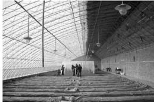
幅(南北長)12m, 棟高5.5m
