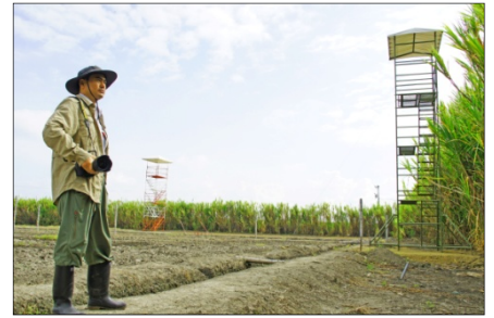
観測塔2棟完成時
