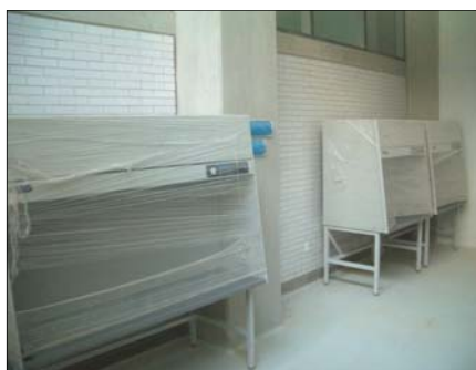
写真 2 実験室の機械整備の様子(※2)
