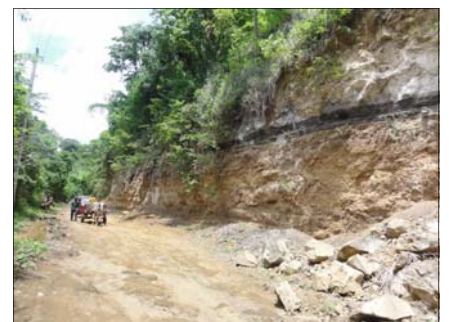
写真 3 流域内生活道路沿いの斜面崩壊
