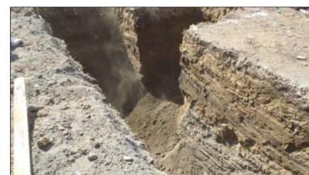
集合住宅近くでの掘削溝 ( 2 )
