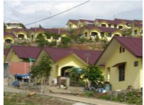
大規模な宅地造成と住宅の建設 (中国インドネシア友誼村)
