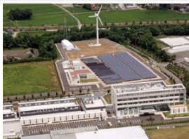
福島再生可能エネルギー研究所
