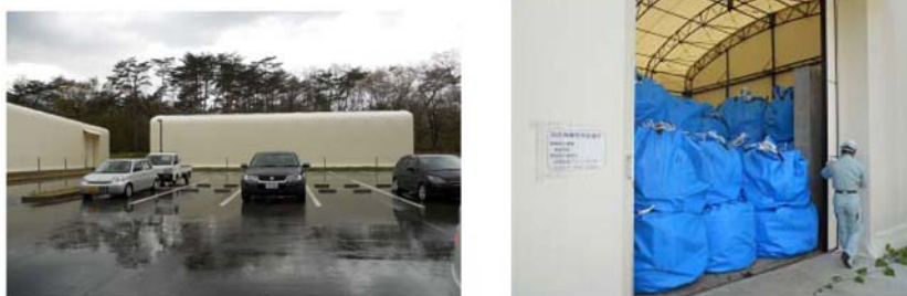
高濃度汚染飛灰の保管用テント（焼却施設内）
