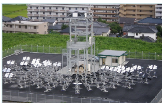
図10 ビームダウン太陽集光システム(宮崎大)
