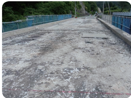
図1 道路橋床版の土砂化
