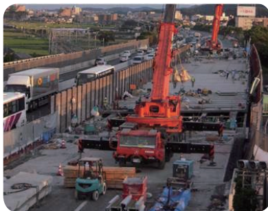
図2 供用中の高速道路等において、交通規制の短縮および高耐久化を実現するプレキャスト製品の開発
