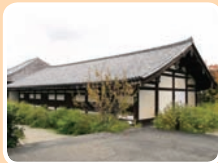
▲図2 元興寺禅室全景（北から）
