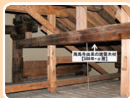
▲図3 元興寺禅室屋根裏 矢印の部分が飛鳥寺由来の建築部材
