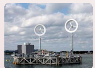
図2 博多湾に設置された海上風力発電浮体(平成23年12月)
