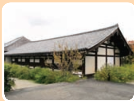
▲図2 元興寺禅室全景（北から）
