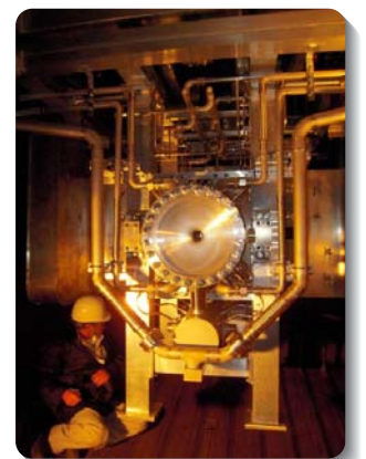
図3 ニュートリノ生成施設でニュートリノの親粒子であるパイ中間子を神岡に向けて収束するための“電磁ホーン”。32万アンペアのパルス電流で運転される。
