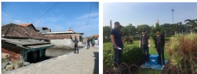
写真-4 1階部分が沈下し水没した家屋(左)、GPS計測点(右中央)
