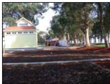
(写真 2) 工事完成
