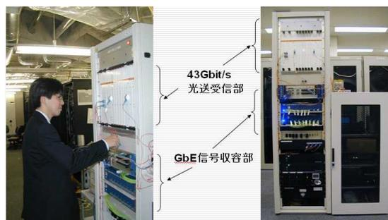
図4：世界初の43Gbps実験用キャンパスバックボーン
