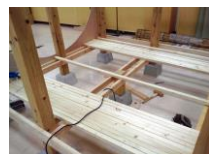
インテリア(床組施工)
