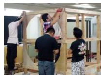
エクステリア(外壁施工)
