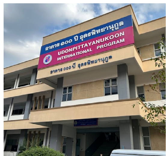
写真 1 International Program の建物 11
