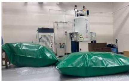
使用済NMRからのヘリウムガス回収
